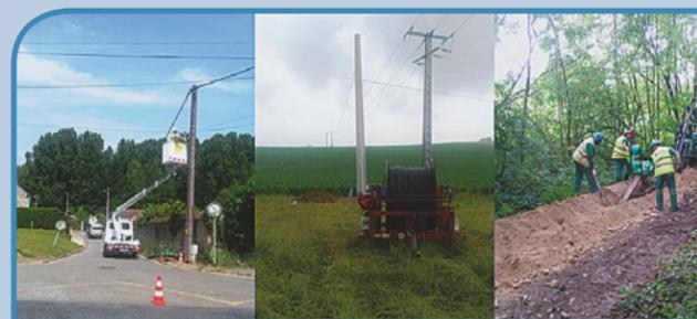
Déploiement de la fibre optique : utilisation des infrastructures existantes, réalisation de tranchées. Raccordement d'une armoire
