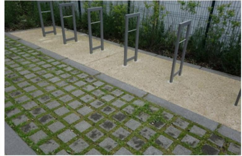
Principe de revêtement perméable
