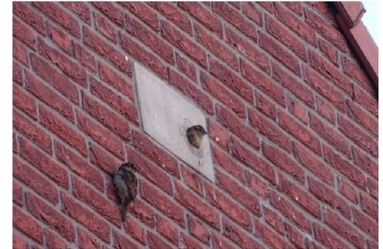
Principe de nichoir intégré dans la construction
