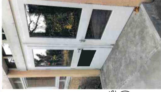
Remplacement porte avec unité de passage conforme (0,90 m)
